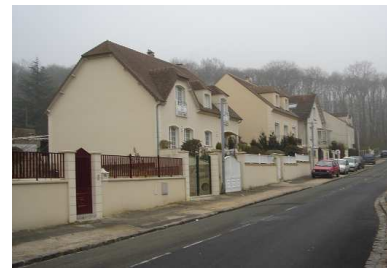
Grands logements récents à Orsay
