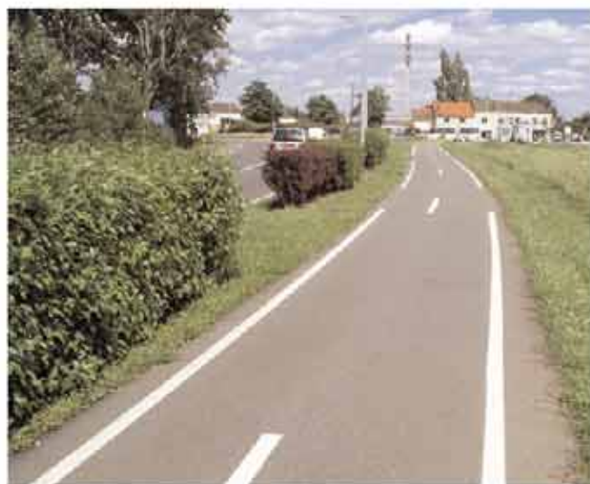
Enrobé en bon état
