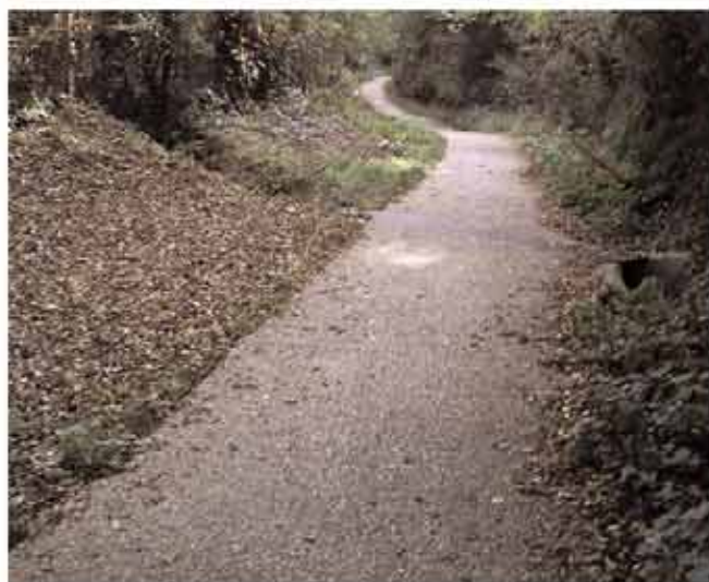
Béton en bon état
