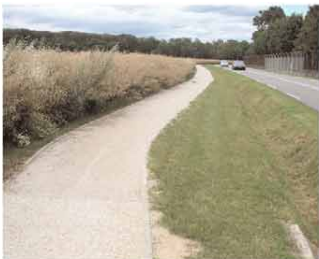
Stabilisé en bon état
